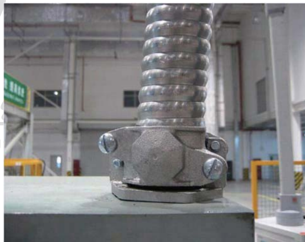
电缆铠装接地图示
